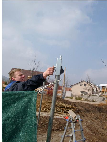
Zugseil durch Ringschraube am Aufsatzrohr fädeln.
